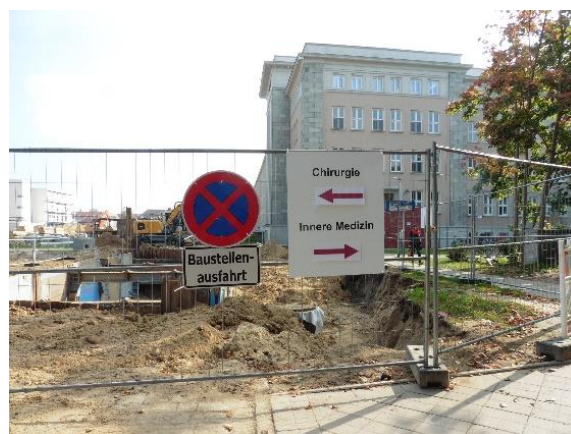
Bild 2 Regenrückhaltebecken IV an der Schillingallee.
