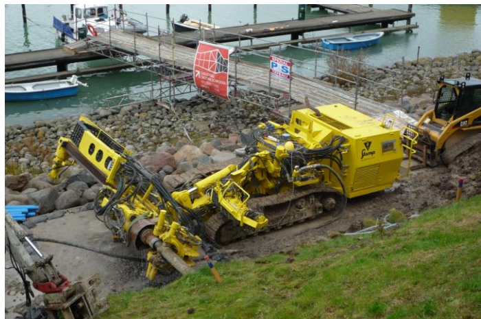
Bild 3 Herstellung der Horizontalbohrung am Hangfuß
