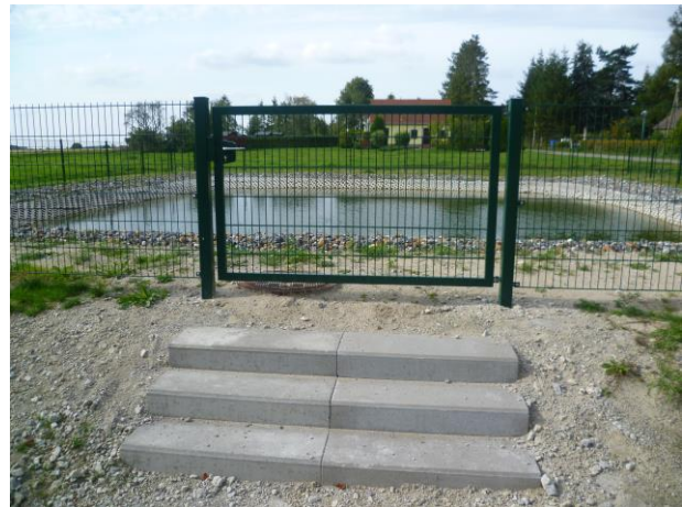
Bild 2 Zustand nach der Bauausführung
