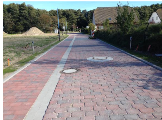
Bild 2: Fertiggestellte Planstraße A
