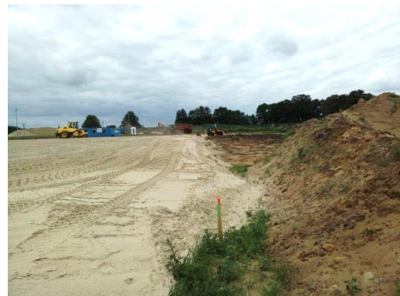
Bild 2 Auffüllung der Gründung des Bauernmarktes und Abtrag bis OK Sandhorizont
