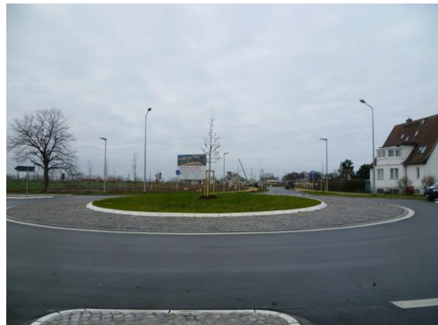
Bild 2 Neuanlage eines Kreisverkehrs in der L 12
