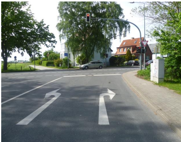
Bild 1 Blick auf die Landesstraße vor Knotenumbau (03/13)
