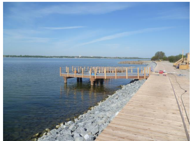
Bild 2: Zustand nach Bauausführung Deckwerk mit Stegen und Rampe für einen barrierefreien Zugang
