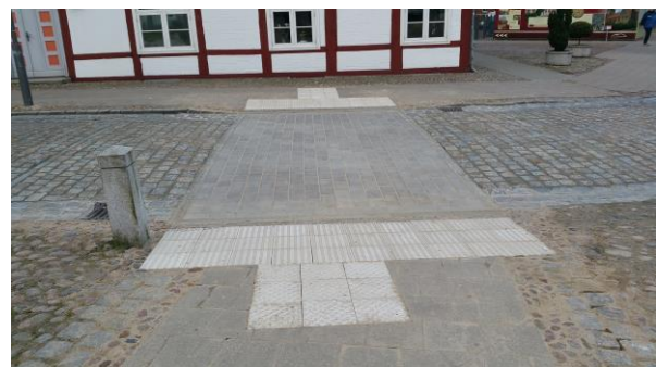
Bild 4 barrierefreie und blindengerechte Querung mit eindeutiger Führung der Fußgänger, nach dem Bau
