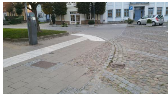
Bild 2 barrierefreie und blindengerechte Querung mit eindeutiger Führung der Fußgänger, nach dem Bau
