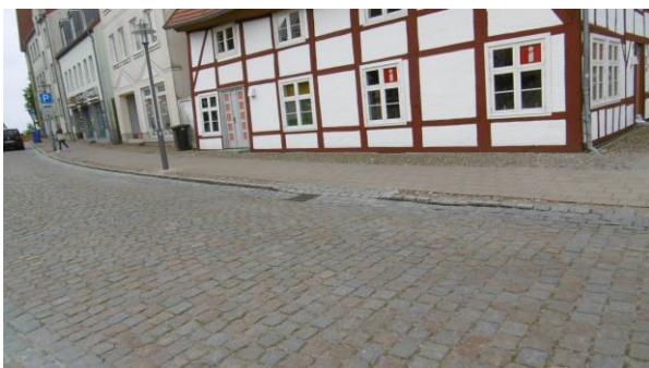
Bild 3 Querung an der Touristeninformation, vor dem Bau
