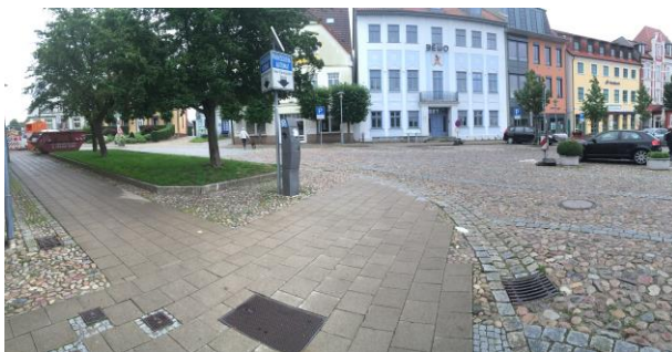
Bild 1 unübersichtliche u. schlecht begehbare Querung an der Commerzbank, vor dem Bau
