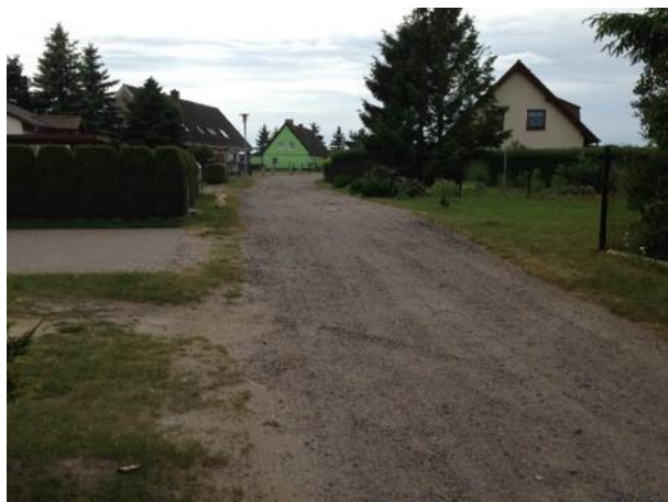
Bild 1 Ausgangszustand – geschotterte Fahrbahn
