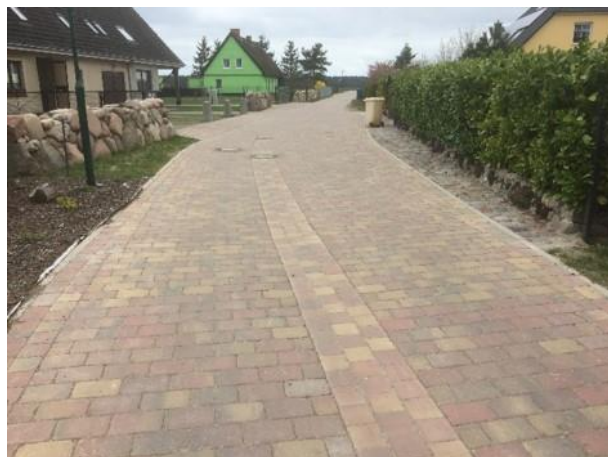
Bild 2 Feldstraße nach Fertigstellung mit Pflasterdecke und neuer Straßenbeleuchtung
