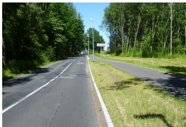
Bild 2 Radweg nach Fertigstellung
