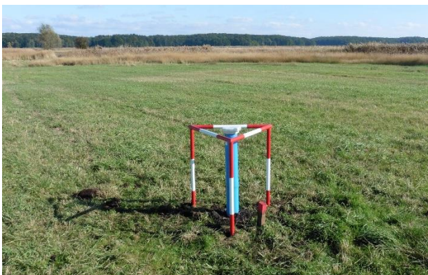
Bild 1 Grundwassermessstelle im Polder
