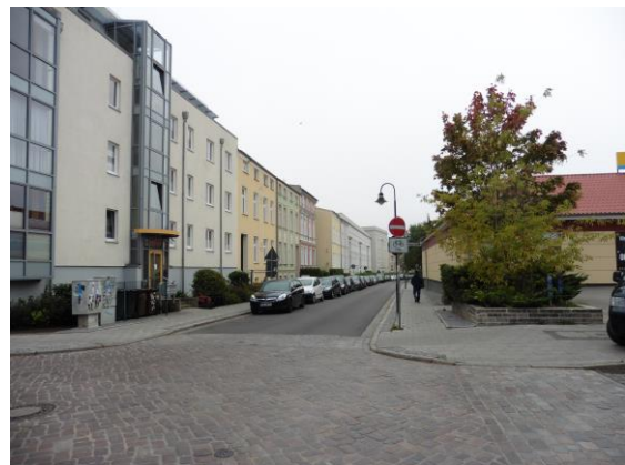
Bild 2 Paulstraße nach Fertigstellung
