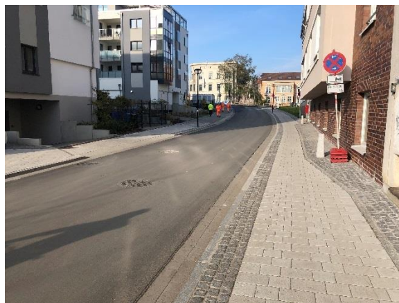
Bild 2 Bleicherstraße fertig gestellt
