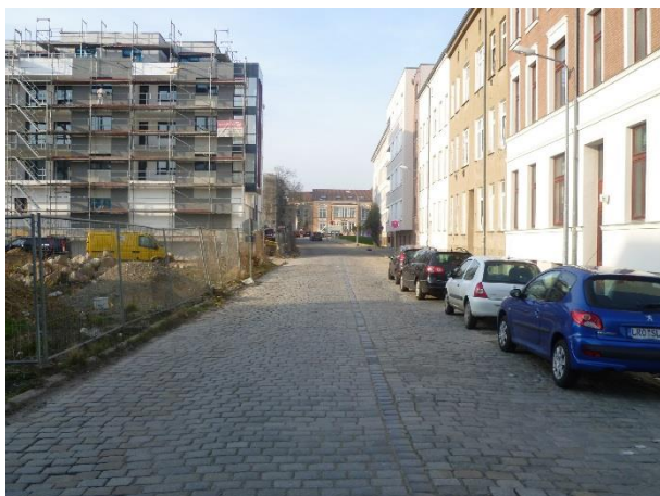
Bild 1 Bleicherstraße vor der Sanierung
