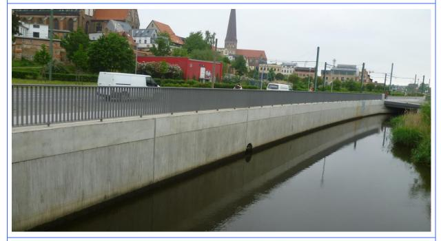
Uferwand Neue Warnowstraße/Fischerbruch, verankerte Spundwand/Betonverschalung, Straßengründung vermörtelte Stopfsäulen, zusammen mit Brücke Bleichergraben/Einlaufwehr
